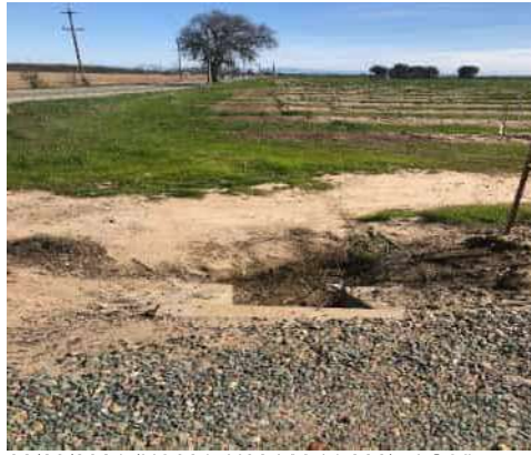
02/23/2021 (NA0017U08 LM:14.306) : LS View: Headwall on LS toe.
